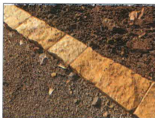
Fot. 2. Kamienne obrzeże ścieżki z kostki dolomitowej
