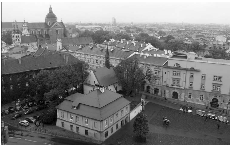
Ryc. 4. Polska. Kraków. Widok z Wawelu na jego otoczenie od strony północnej. Fot. M. Baścik. 2007. W latach 40. XX wieku nastąpiło uporządkowanie otoczenia Wawelu, rozpoczęte usunięciem chaotycznej zabudowy, pozbawionej wartości zabytkowej (aut. Adolf Szyszko-Bohusz)
