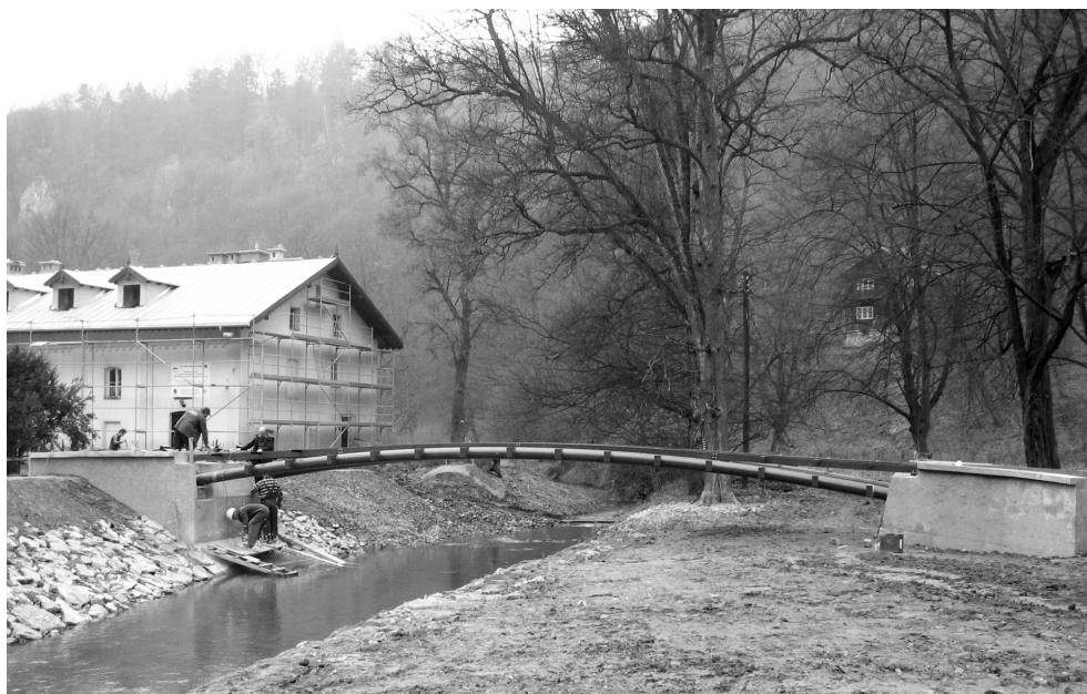
Fot. 3. Przebudowa kładki na Prądniku. Fot. J. Partyka
