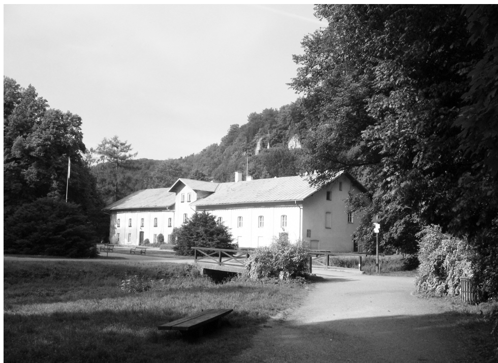
Fot. 1. Budynek „Hotel Pod Łokietkiem” i jego otoczenie przed rozpoczęciem generalnego remontu. Czerwiec 2008 r. Fot. J. Partyka
