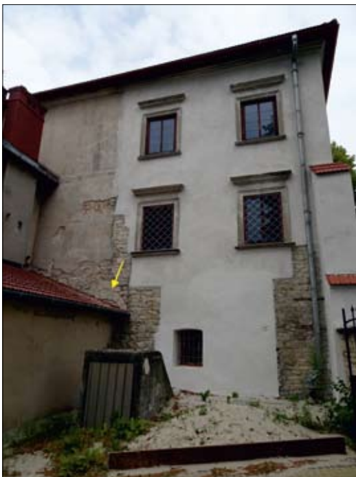
Ryc. 4. Fragment elewacji plebanii od strony dziedzińca (strzałką oznaczono romański łęk). Fot. J. Firlet
