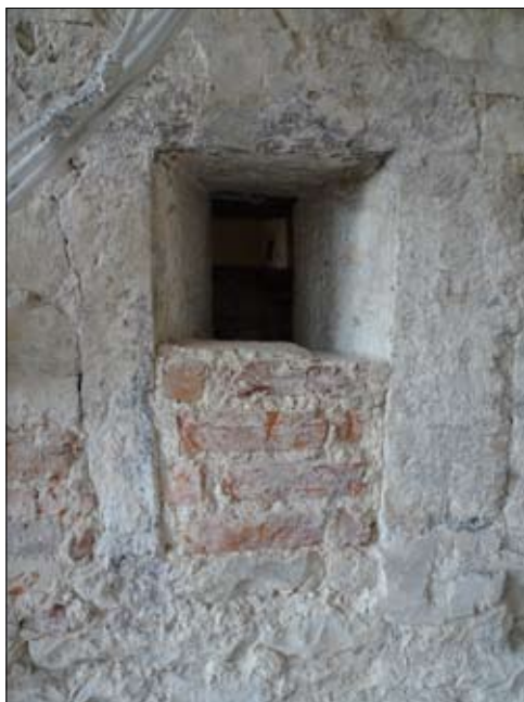
Ryc. 6. Okienko o kamiennym obramieniu na I piętrze. Widok od zewnątrz. Fot. J. Firlet
