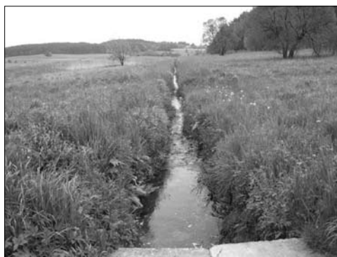
Ryc. 3. Dłubnia poniżej oczyszczalni ścieków w Trzyciążu
