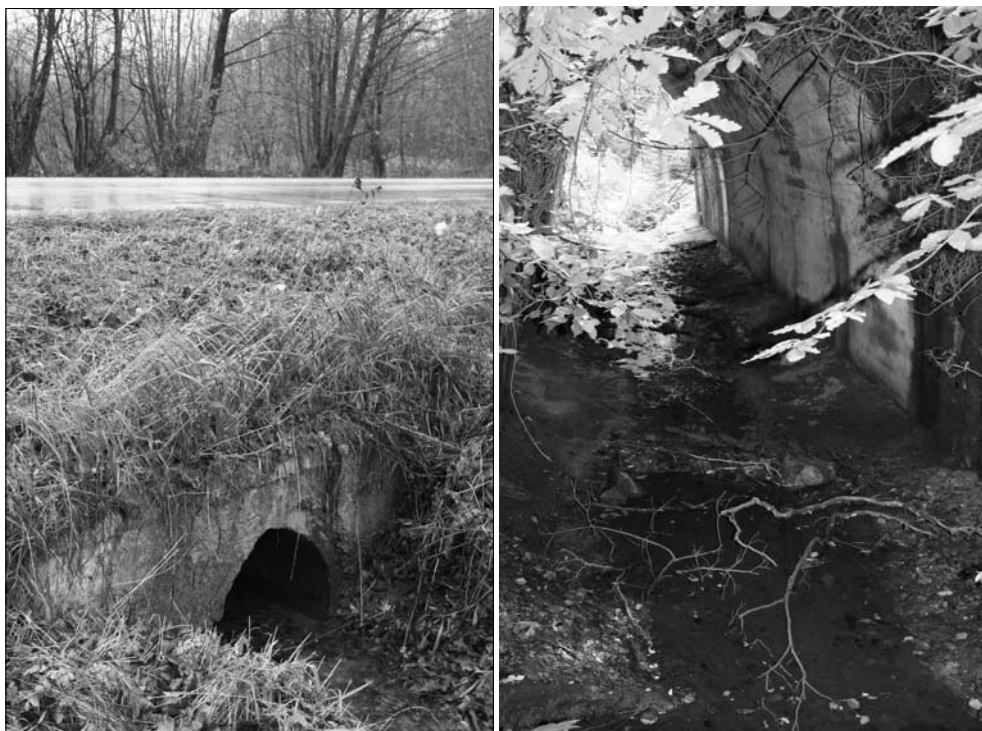
Ryc. 4. Przepusty przeznaczone do przebudowy na zespolone przejścia dla zwierząt w Świętokrzyskim Parku Narodowym. Fot. D. Wojdan
