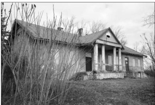
Ryc. 4. Giebułtów. Dwór. Fot. Z. Beiersdorf, 2015
