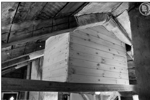
Ryc. 4. Adaptacja strychu do ochrony nietoperzy w willi „Uroczna”. Fot. A. Fiskies
