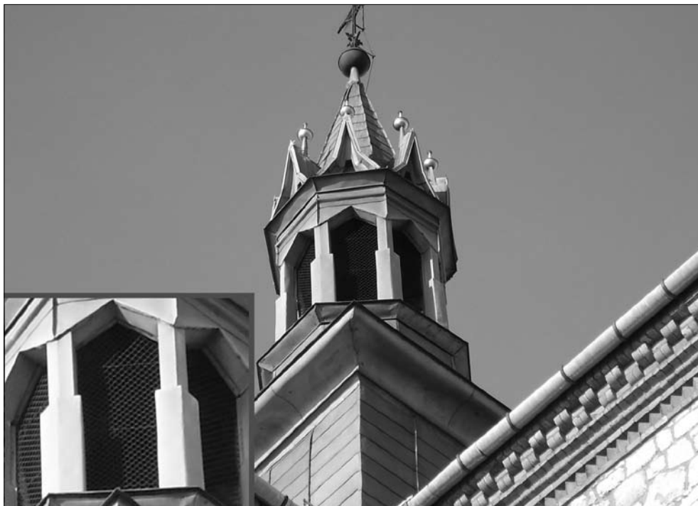
Ryc. 9. Zakratowane otwory w kościelnej wieży w miejscowości Smardzowice, otulina Ojcowskiego Parku Narodowego, styczeń 2008. Fot. M. Turzański
