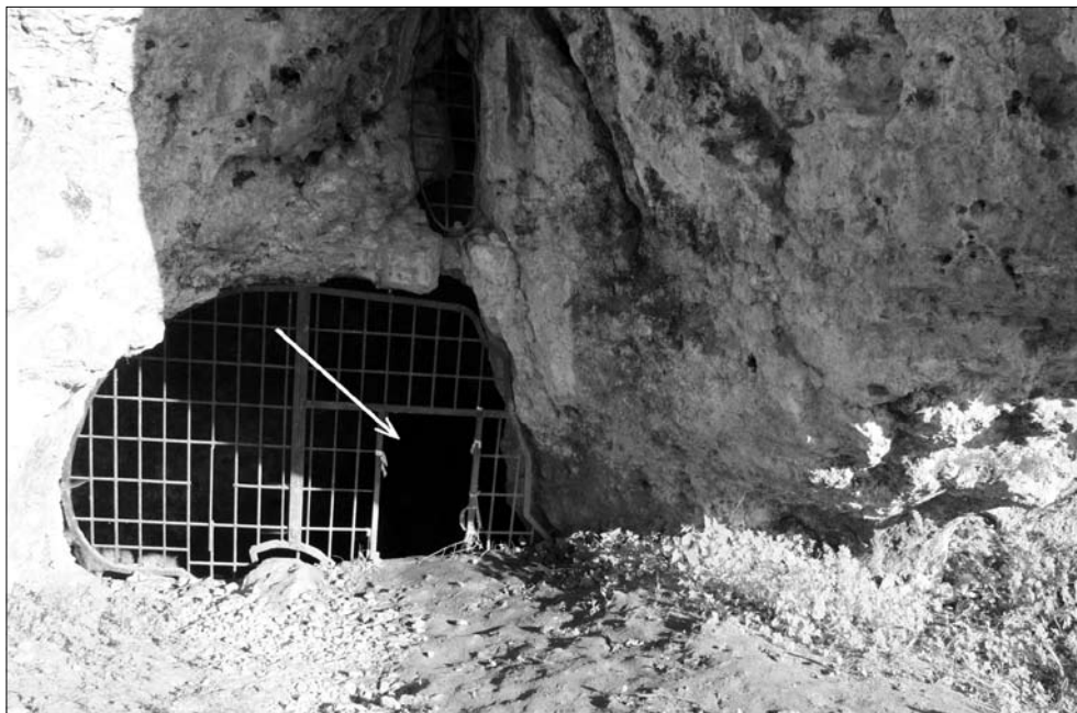
Ryc. 4. Widok na otwór wejściowy do Jaskini Biśnik, który z powodu braku solidnych zabezpieczeń (brak drzwiczek) stanowi zagrożenie dla turystów. Fot. K. Kasprowska-Nowak
