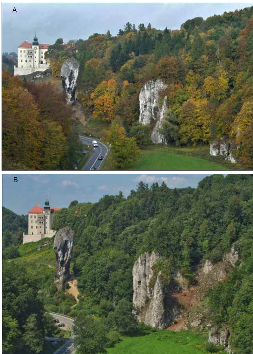
Ryc. 2. Skąły Mickiewicza: A – przed zabiegiem 19.10.2016, B – po zabiegach 17.08.2018. Fot. J. Baran. Fig. 2. Mickiewicz rocks: A – before treatments 19.10.2016, B – after treatments 17.08.2018. Photo by J. Baran.
