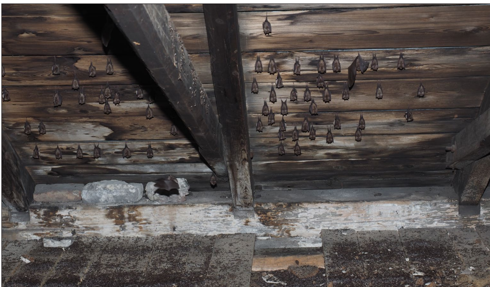
Fot. 1. Podkowce małe na strychu kotłowni szpitala uzdrowskiego. Fot. R. Szkudlarek Photo 1. Lesser horseshoe bats Rhinolophus hipposideros in the attic of the spa hospital boiler house. Photo by R. Szkudlarek
