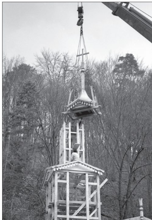
Ryc. 11. Montaż nowej wieżyczki na sygnaturkę na kaplicy pod wezwaniem św. Józefa Rzemieślnika w Ojcowie w 1996 r. Fot. R. Cieślik
