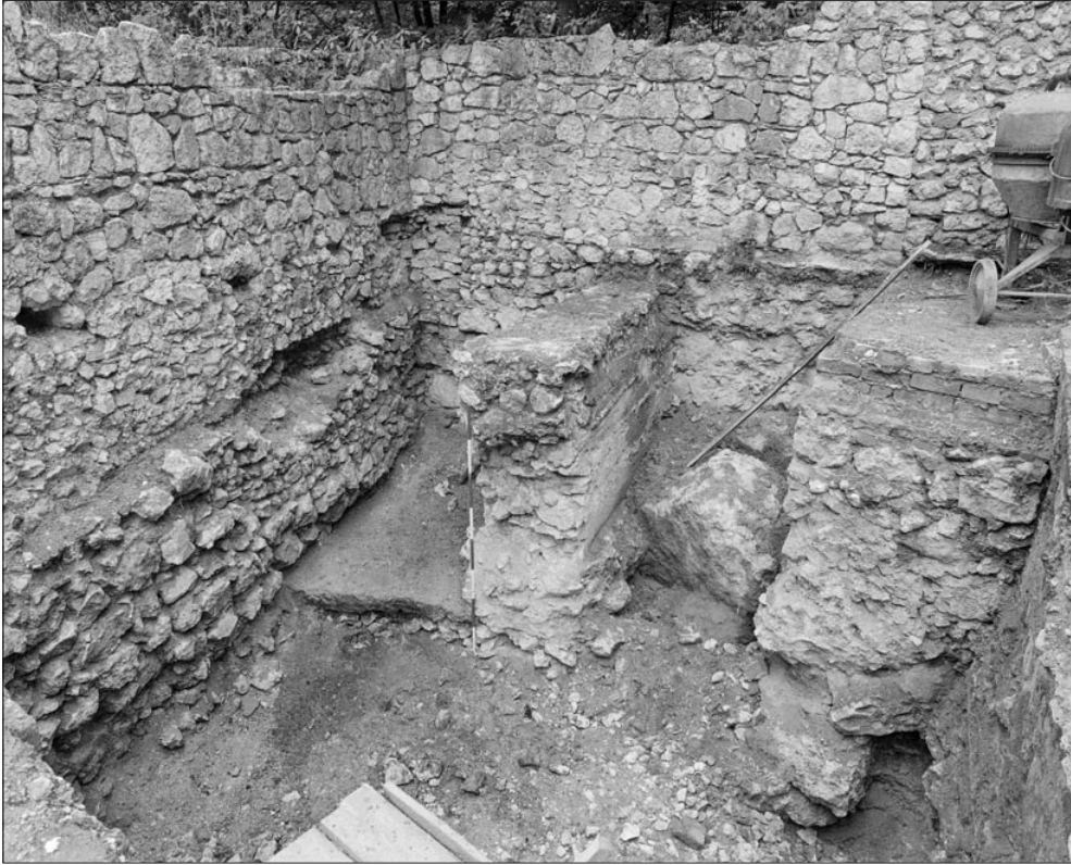
Ryc. 7. Korzkiew – zamek. Mury w południowo-zachodniej części dziedzińca, w budynku „SW”. Widok od północnego wschodu. Fot. T. Kalarus
