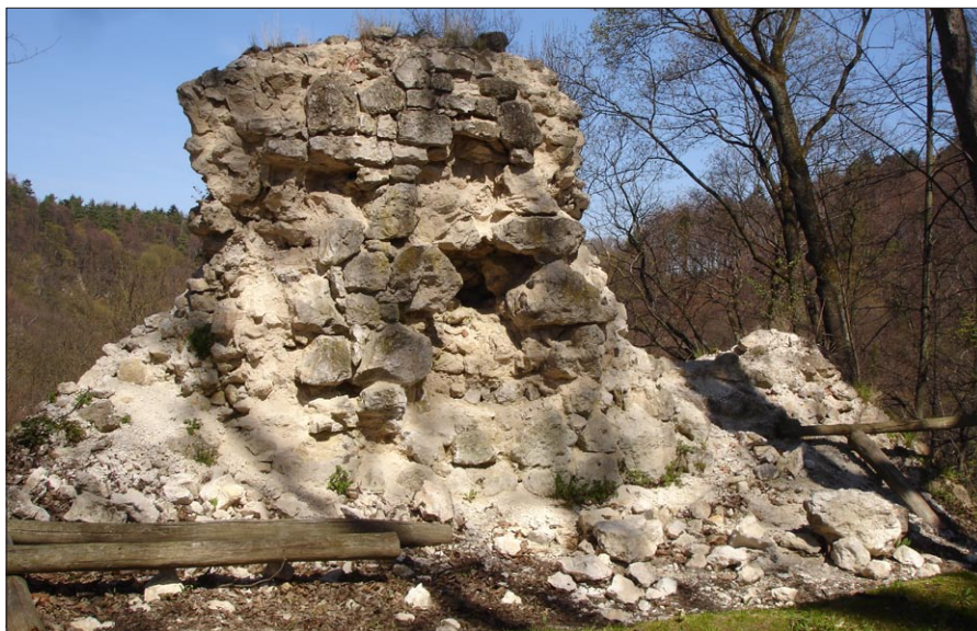
Ryc. 3. Fragment muru obronnego od strony północnej przed rozpoczęciem prac w 2006 roku. Fot. M. Bicz-Suknarowska
