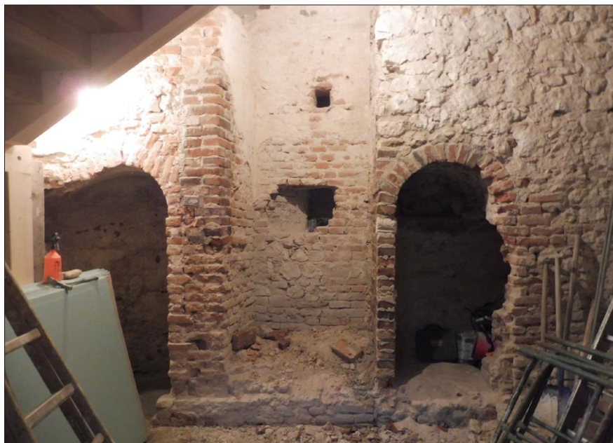
Ryc. 16. Wnętrze wieży podczas prac konserwatorskich. Fot. M. Bicz-Suknarowska
