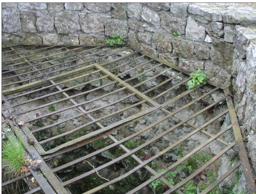
Ryc. 9. Studnia przed remontem. Fot. M. Bicz-Suknarowska
