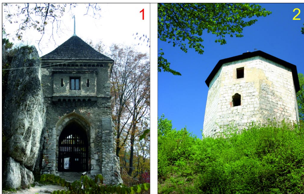
Ryc. 2. 1 – brama (widok od zachodu); 2 – wieża (widok od południa): stan przed rozpoczęciem prac wykonanych w latach 2018–2019. Fot. M. Wojenka
